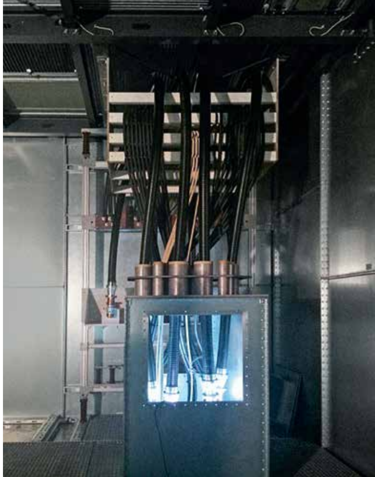
شتاب دهنده به وزن ۱۰۰ تن و ارتفاع ۱۶ متر در پادوا. شتاب دهنده محل استقرار تجهیزاتی است که ولتاژ یک میلیون ولت را تامین می کنند.
